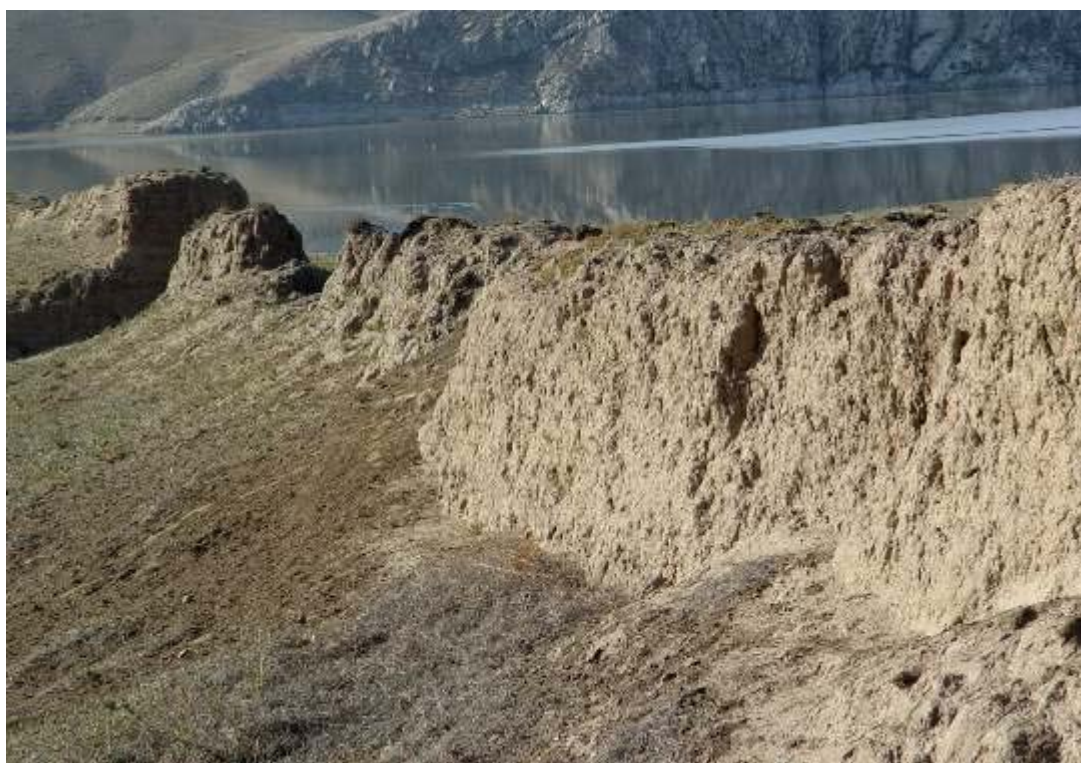
图一四 乌拉特前旗小余太乡增隆昌古城西墙土筑墙体
