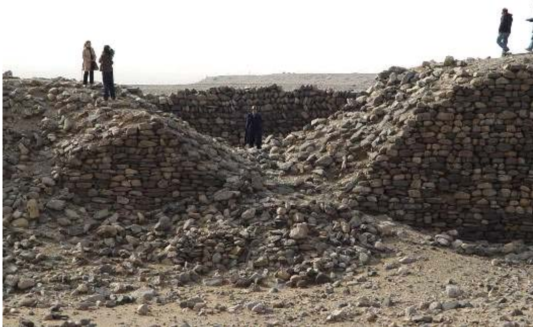
图二〇 磴口县鸡鹿塞南墙城门及瓮城（北——南）
