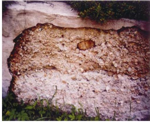
图4 水泥修复后表面泛碱并产生大面积脱落
