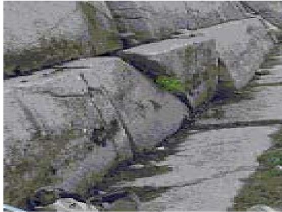
图2 将军坟石材上产生的裂隙
