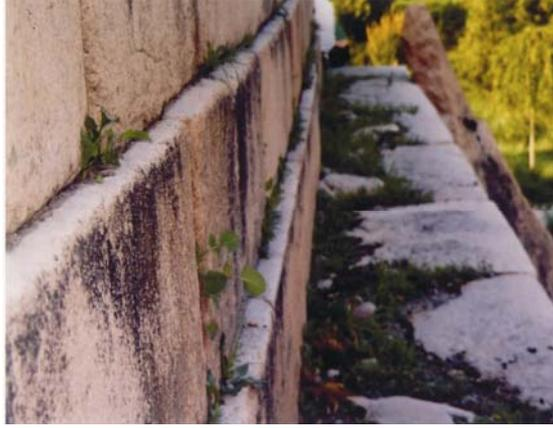
图7 化学风化腐蚀层
