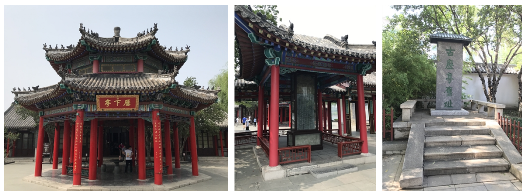
图 2.2.1a、2.2.1b、2.2.1c 历下亭、御碑亭、古历亭旧址
